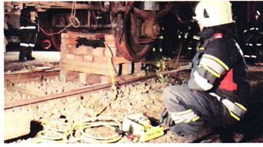
Mittels Hebekissen können sogar Eisenbahnwaggons mit wenig Aufwand angehoben werden.
